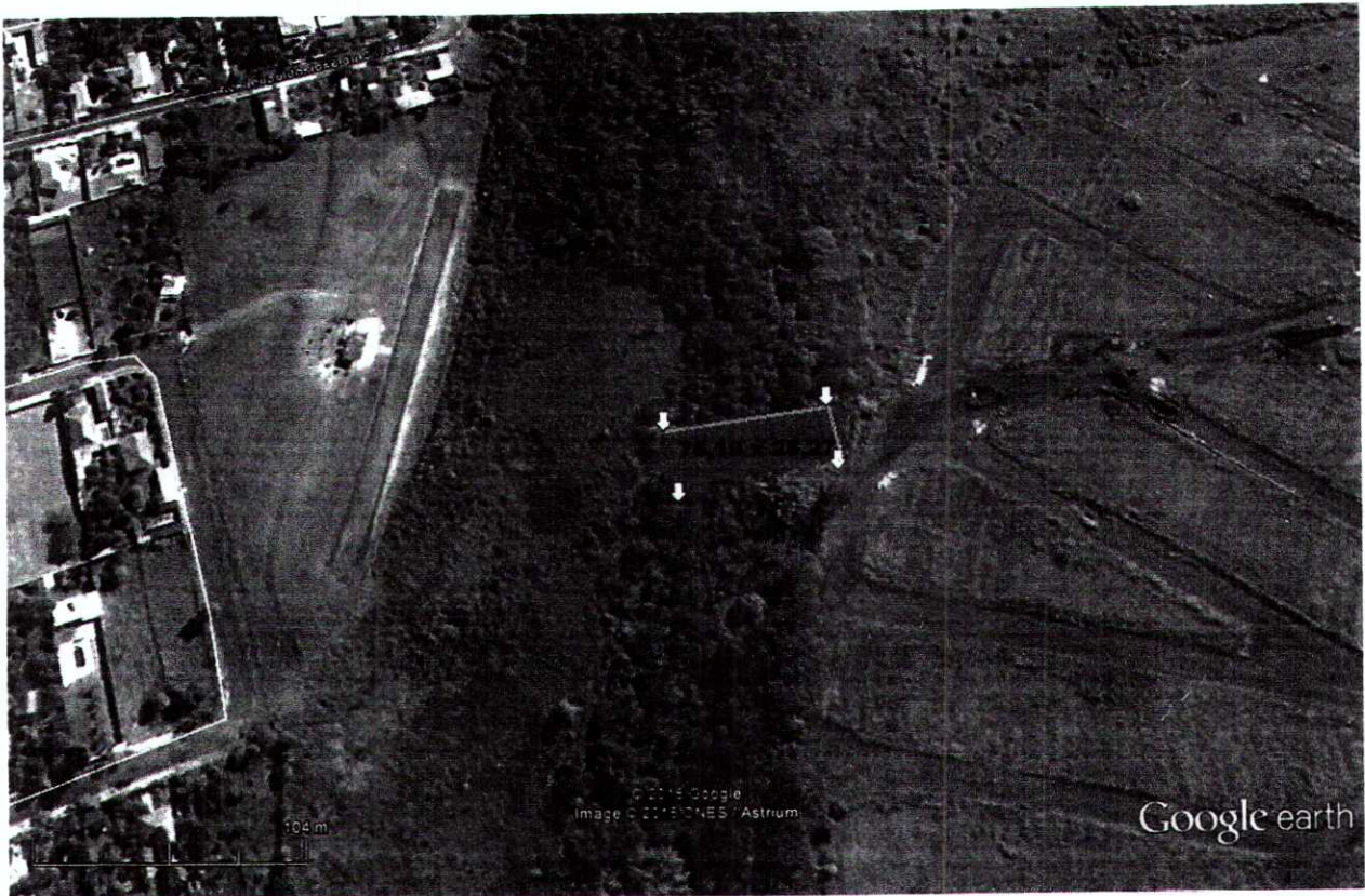
FIGURA 05B VISTA AÉREA DO LOCAL PARA A INTERVENÇÃO
