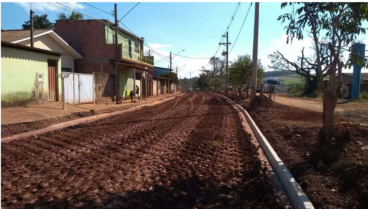
Compactação Executada com Pé de Carneiro
