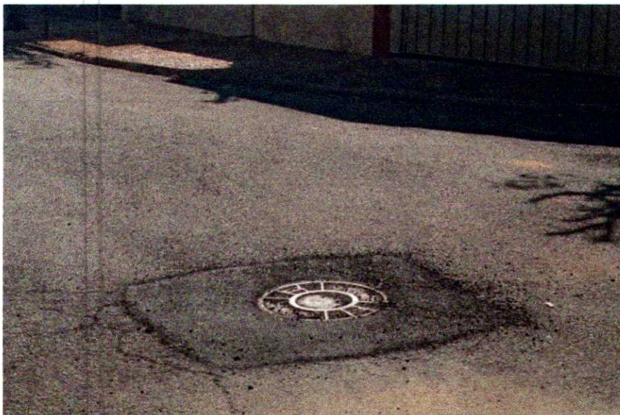
Imagem 2 - Reparo Asfáltico localizado a Rua Ignacia Zadra Fonseca, 10 - Jardim Anésia.
