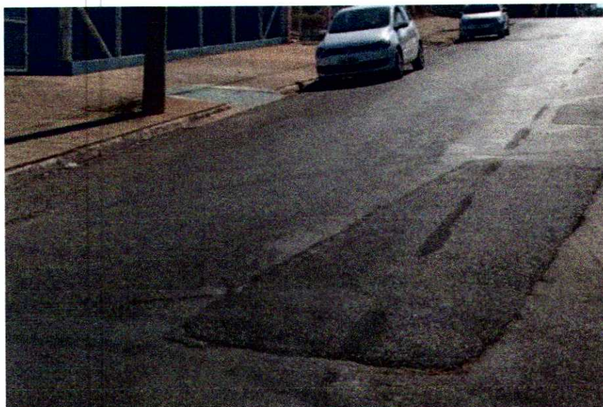
Imagem 1 - Reparo Asfáltico localizado a Rua José Olivieri, 130 - Parque Residencial Cristo Redentor.
