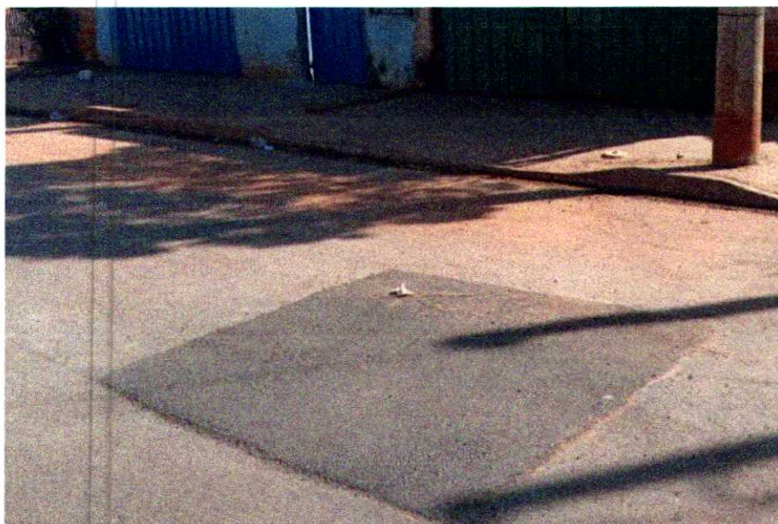
Imagem 5 - Reparo da rede de abastecimento de água na Av. Estrada Velha de Descalvado, 520 - Jardim Anésia.
