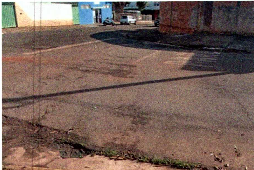
Imagem 4 - Vistoria na Rua Maria Parras Pelissari, 110 - Jardim Anésia, não identificado obstruções nas redes de água e esgoto.
